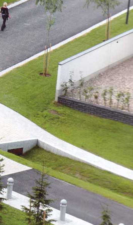
1.-2. Toppilansaari Park, Oulu, Finlandia – progetto: Atelier Dreiseitl, 2003-2004. Le spine verdi che si innestano all'interno del tessuto edilizio sono costituite da un sistema di pavimentazioni drenanti, canali verdi filtranti e di collettamento delle acque meteoriche, e sono connesse con i bacini di biofitodepurazione esterni al quartiere
