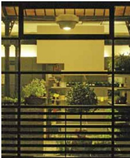
termico dell'edificio e al controllo ambientale. Alcune scelte impiantistiche hanno positivamente contaminato il progetto: una serie di *shed* in copertura e grandi lucernari piani consentono l'ottimizzazione degli effetti termici e lo sfruttamento dell'illuminazione naturale. Le vetrate isolanti stratificate sono di tipo basso-emissive e schermate da un doppio piano in acciaio inox, forato in modo tale da consentire sempre la radiazione diffusa e la radiazione solare diretta.
